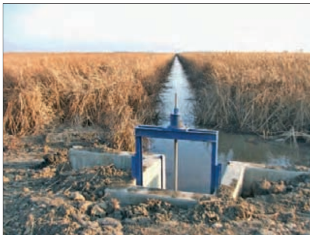
Башаидски друм; новембар 2011; устава уз Башаидски друм којом се регулише ниво воде у доводном каналу и њено пропуштање у Поштину копов (фото: С. Пузовић)
