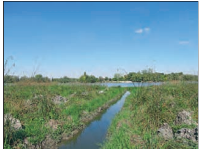
Бегечка јама; јун 2014; канал дужине 150 m ископан је између језера Јама и рукавца Велики Дунавац, ради миграције риба у оба правца и бржег протока воде (фото: Б. Марић)
