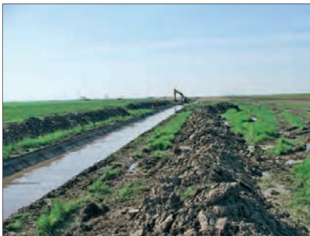
Мали угар; април 2010; изградња доводног канала од ДТД канала до Поштиног копова у оквиру пројекта уређења водног режима у заштићеном подручју (фото: С. Пузовић)
