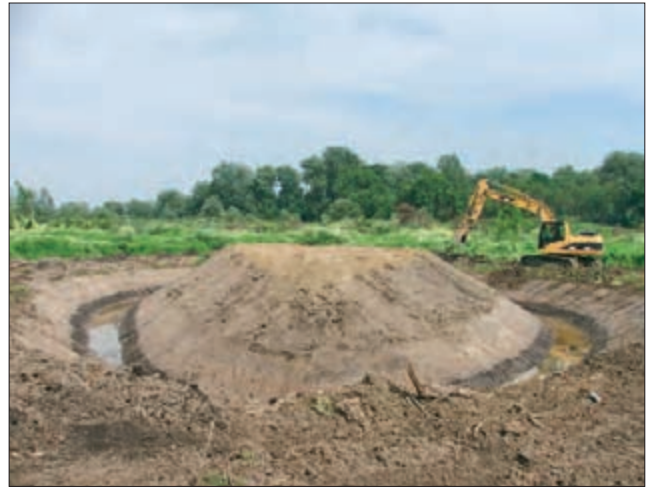
Ливаде Купиника; август 2007; изградња острва птица од земље која је добијена формирањем воденог заштитног огледала око њега (фото: С. Пузовић)
