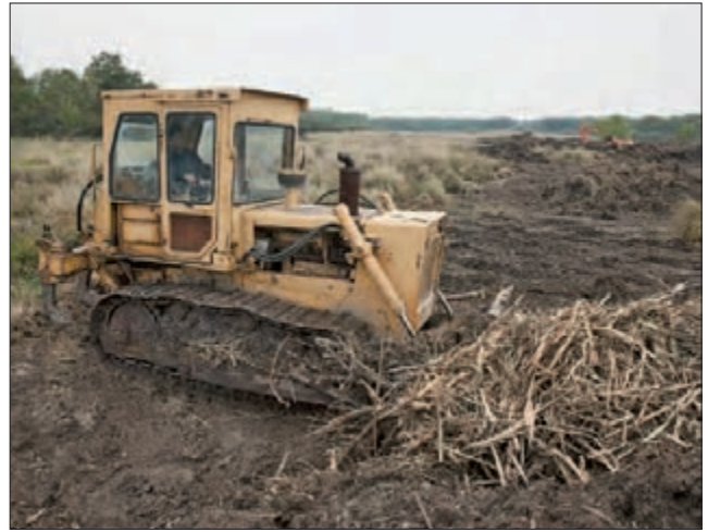
Шаркањ; октобар 2015; интензивни радови на ревитализацији барских станишта уклањањем жбунасте вегетације, наноса остатака дрвећа и површинског седимента (фото: С. Ковач).
