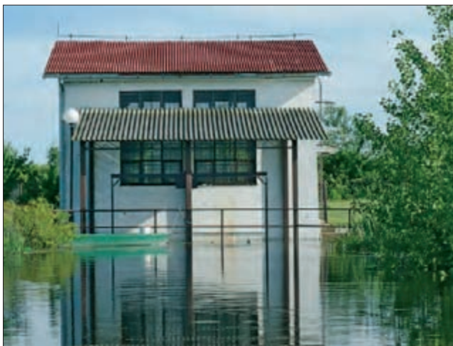
Трсковача; мај 2014; Црпна станица „Трсковача“ која служи за одводњавање депресије и ради као секундарна у систему Врањ; Поглед са сабирног канала (Фото: М. Ћуић)
