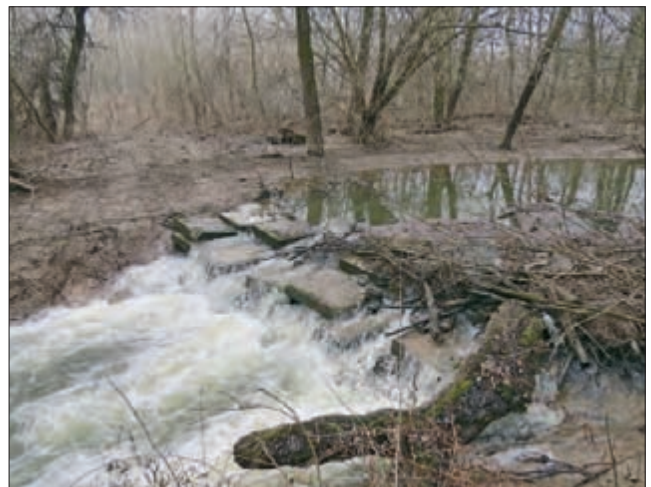
Споредни канал око Купиника; децембар 2015; изграђена/обновљена брана на споредном каналу уз Вок коришћењем бетонских плоча, ради унапређења водостаја (фото: С. Пузовић)
