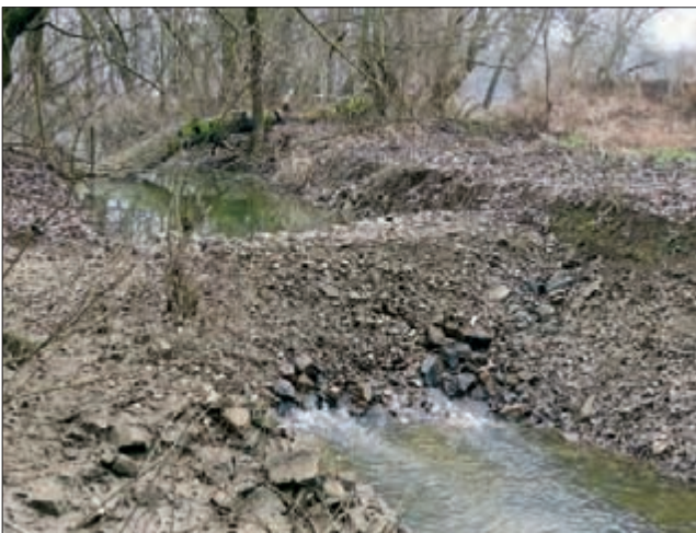
Канал Вок; септембар 2015; изграђена/обновљена камено-земљана брана на Вок у функцији спречавања брзог отицања воде у Саву, при наглој опадању водостаја ( Фото: С. Пузовић)
