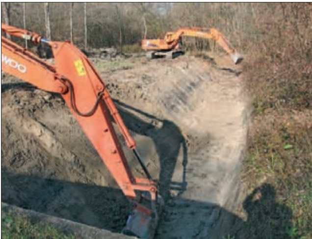
Широки рит; новембар 2008; радови на прочишћавању и ширењу канала како би се обезбедио несметан доток воде у формирану акваторију из оближњег дунавца (фото: В. Милошев).
