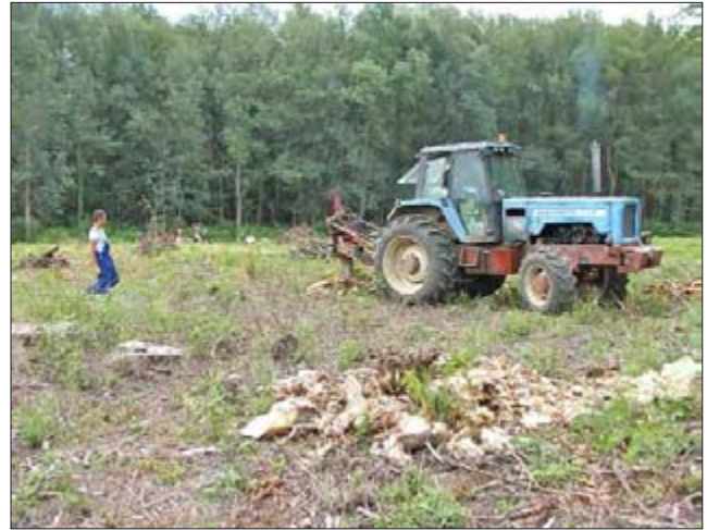
Чењинске ливаде; август 2014; иверање пањева заосталих након уклањања стабала у поступку чишћења; стварање услова за одржавање станишта кошењем/тарупирањем (фото: С. Пузовић)
