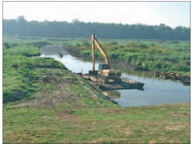
Депресија ка Крстоношића окну; јул 2012; измуљивање водених станишта уклањањем седимента, наноса од поплава и вегетације; коришћење багера на понтону (фото: С. Пузовић)
