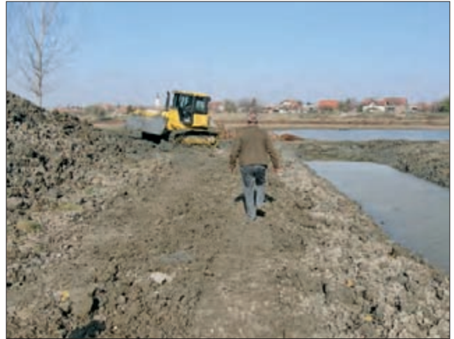
Дунавац, Тиквара; новембар 2008; измуљивање седимента и наноса у Дунавцу уз Тиквару, наспрам Ковиља, ради обезбеђивања сталног присуства воде (фото: С. Пузовић).
