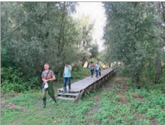
Агла; септембар 2013; дрвени мост изграђен од високе обале код шумске куће до осматрачнице на рубу баре Агле (фото: А. Јефтић).
