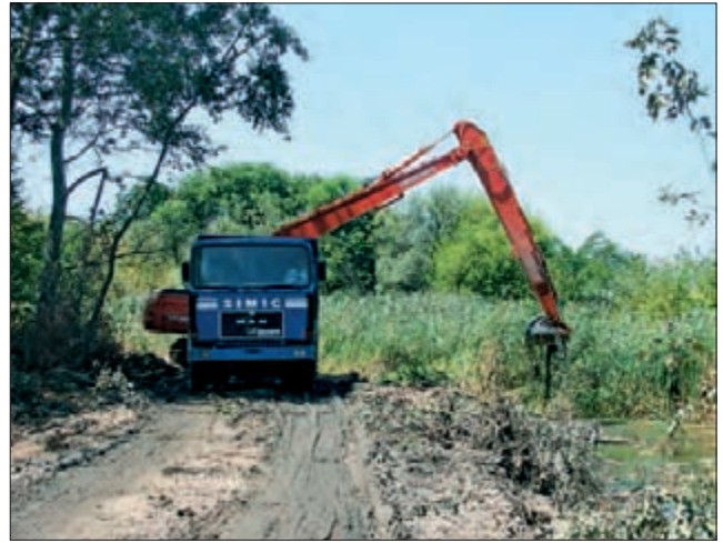
Стари Бегеј, 1 километар; јул 2008; измуљивање корита Старог Бегеја, коришћењем радне стазе на обали, уз одвожење измуљеног материјала (фото: С. Пузовић)
