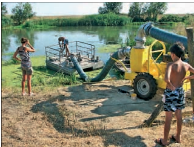
Канал ДТД; август 2013; повезивање усисне корпе и пумпе за пребацивање воде у ископани доводни канал (фото: С. Пузовић)
