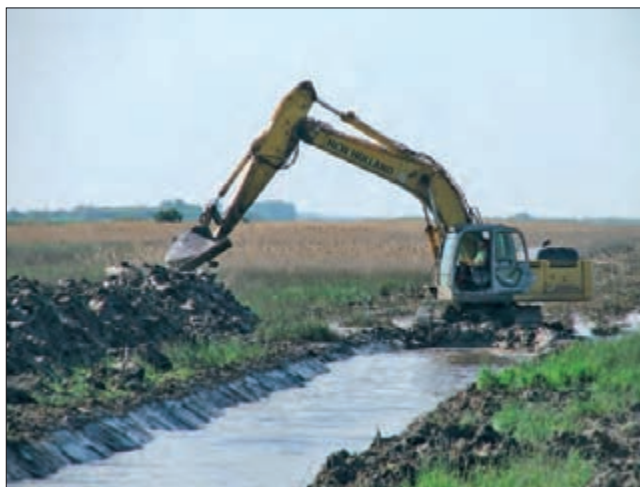
Мали угар; април 2010; формирање воденог корита у депресији за прихват и сакупљање воде из доводног канала, ради накнадног коришћења (фото: С. Пузовић)
