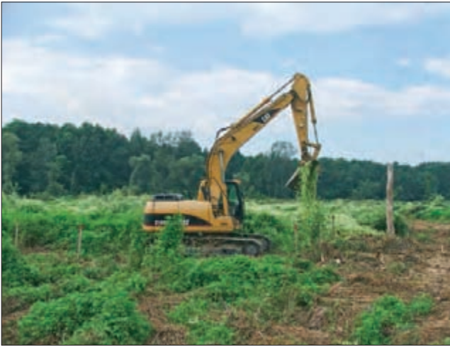
Ливаде Купиника; јул 2007; уклањање жбунасте вегетације и припрема терена за изградњу острва птица и водених окана (фото: С. Пузовић)
