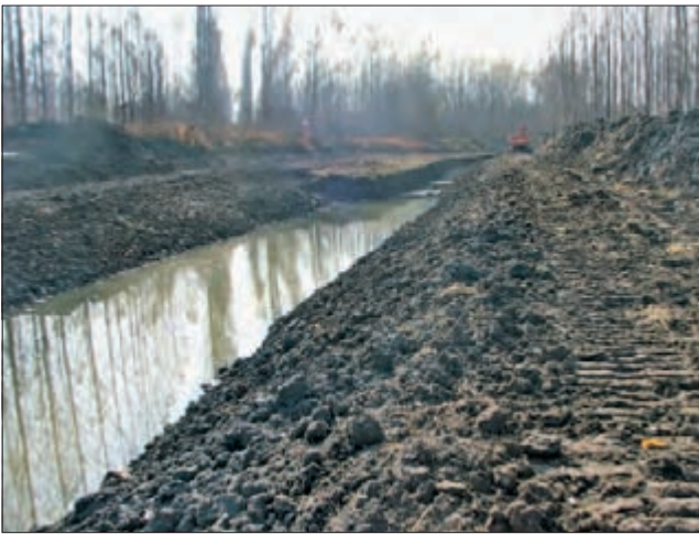
Дунавац, Тиквара; новембар 2008; формирање издужене депресије Дунавца дуге 600 м; разгртање измуљеног седимента на високе обале и околне плантаже топола (фото: С. Пузовић).
