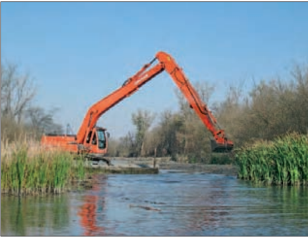
Стари Бегеј, 1 километар; септембар 2008; машински ископ муља и уклањање седимента и наноса, уз коришћење багера и плутајућег понтона (фото: И. Грња)
