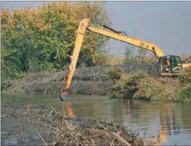
Јегричка код Сирига; октобар 2013; измуљивање корита Јегричке коришћењем багера, уз депоновање муља и вегетације на високој обали; eWAM пројекат (фото: Л. Виг)
