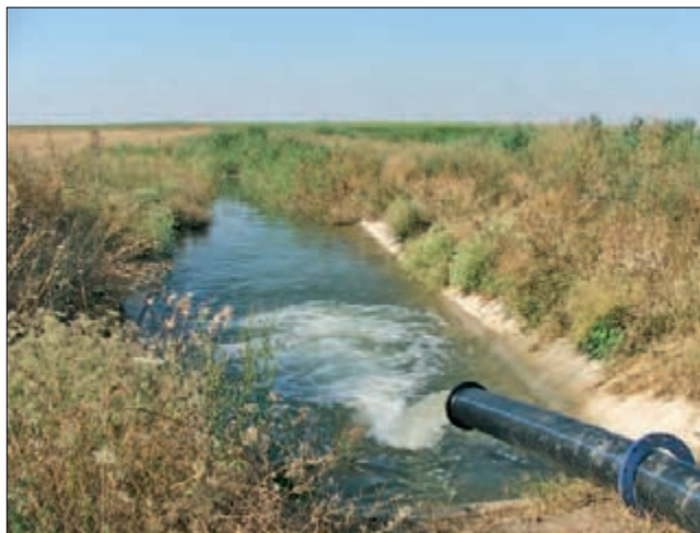
Канал ДТД; август 2013; пребацивање воде у доводни канал у периоду суше, када је ниво воде у кориту Сланог копова на минимуму (фото: С. Пузовић)
